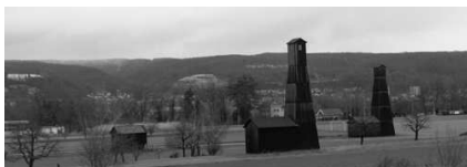
Für die Salzbohrtürme in der Rheinebene wird nicht mehr viel Platz bleiben.
