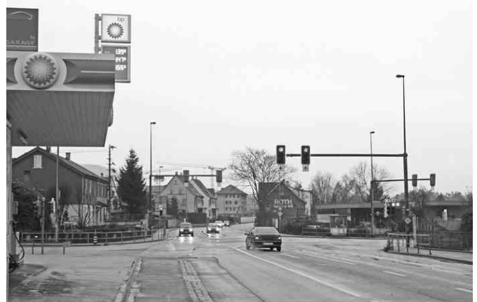
Kunimattkreuzung - von Liestal Richtung Muttenz
