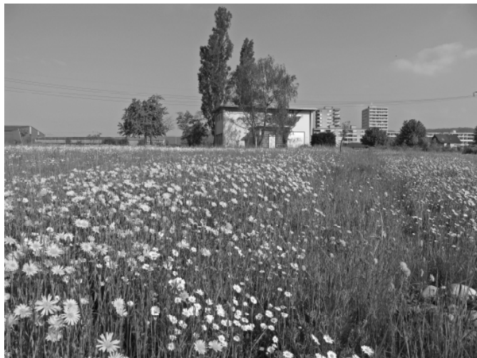
„Altes“ Grundwasserpumpwerk Remeli
