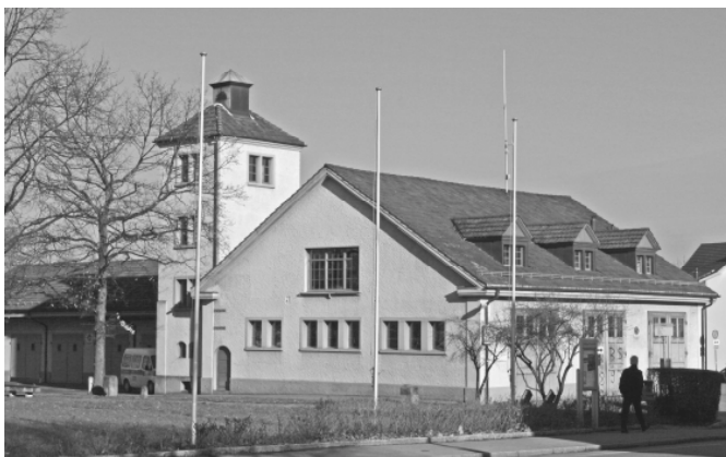
Feuerwehrmagazin an der Oberemattstrasse (Archivfoto)
