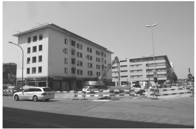
NEUES WIRD ENTSTEHEN: 2013 Güterstrasse - steht noch der Salmen am Bahnhofplatz
