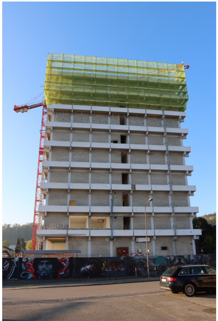
Heute erinnert noch wenig an den einst stolzen Chemiebetrieb Rohner an der Güterstrasse.
